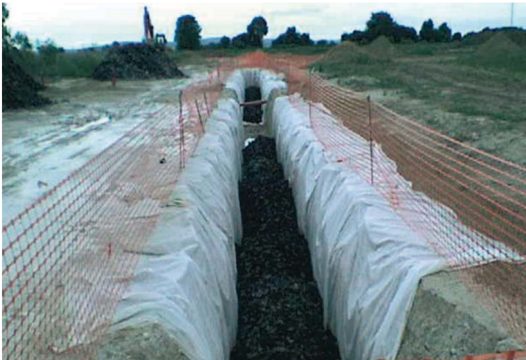
En cours de remplissage
