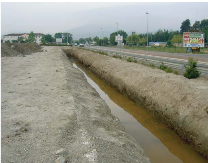
Excavation avant mise en place du geotextile
