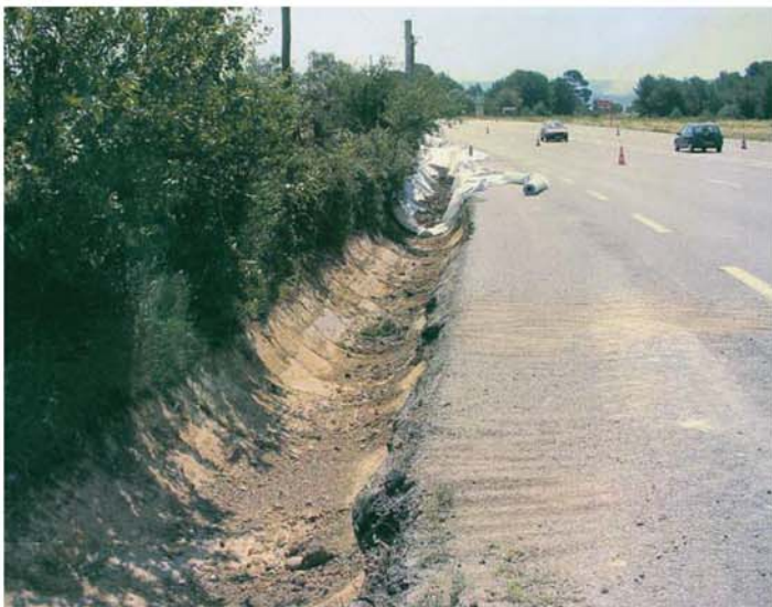
Fossé calibré avant pose du géotextile
