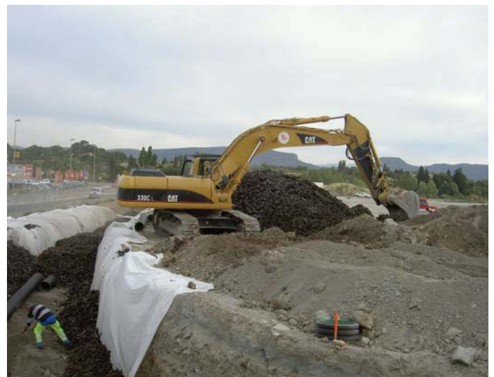
Remplissage en Draincom
