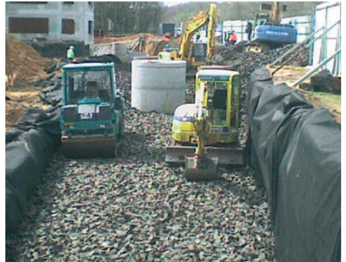
Compactage par couches de 30 cm
