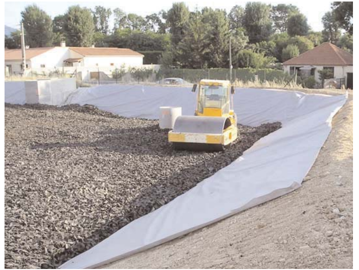
Compactage au rouleau vibrant
