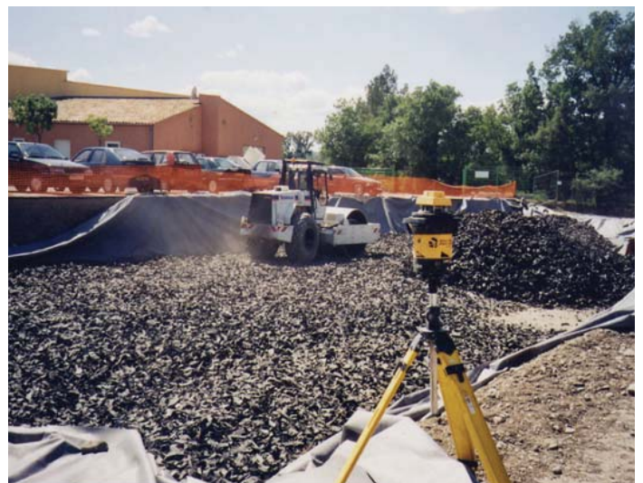
Compactage au rouleau vibrant
