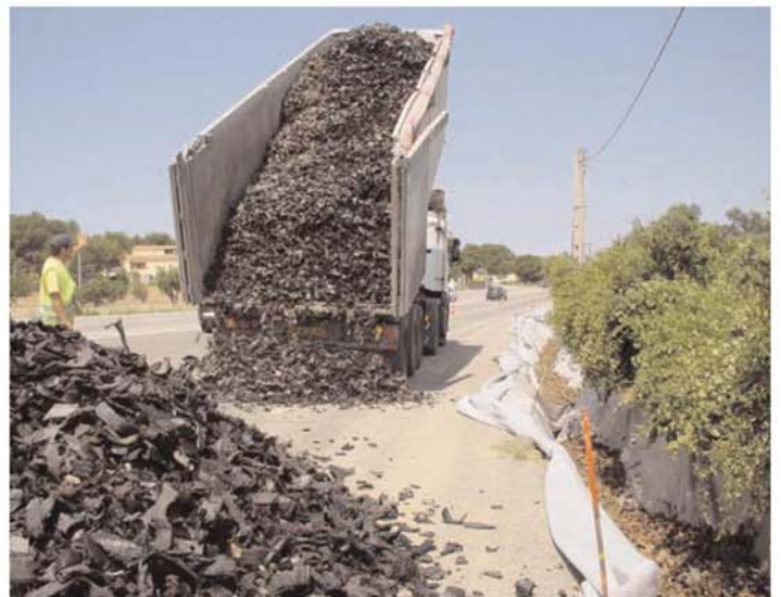
Déchargement du Draingom
