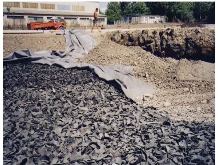
Fin du remplissage et recouvrement par le géotextile avant remblaiement sur 1,5 m
