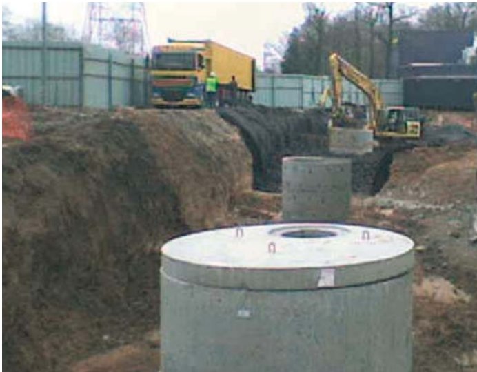
Le terrassement terminé avant pose du géotextile
