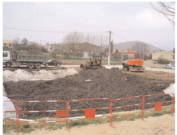
Remplissage en Draingom sur nappe de géotextile
