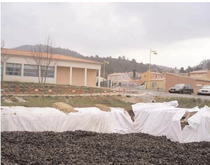
Bassin rempli de 1500 m 3 de Draingom avant couverture par le géotextile
