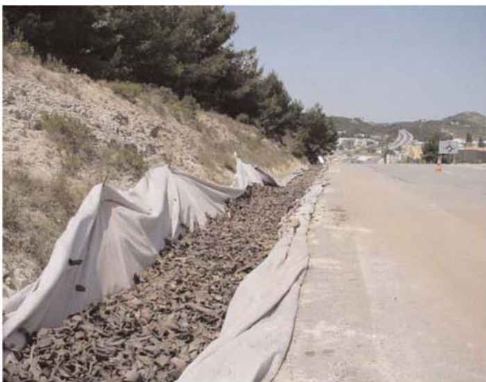
Remplissage du fossé en DRAINCOM
